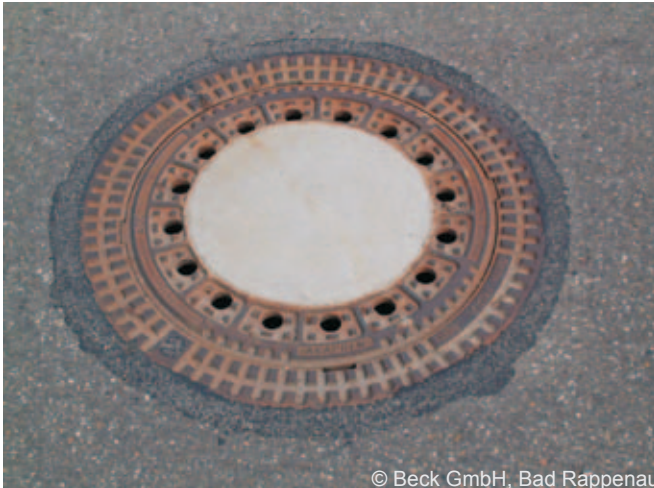
Schachtabdeckung, LW 605, Klasse D 400, System Bituplan®, Rahmen aus Gusseisen, BEGU®-Deckel nach DIN 19584 mit Lüftungsöffnungen
