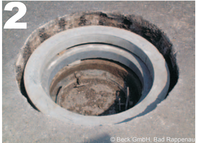
Ausgleichsring und Adapterring ausrichten
