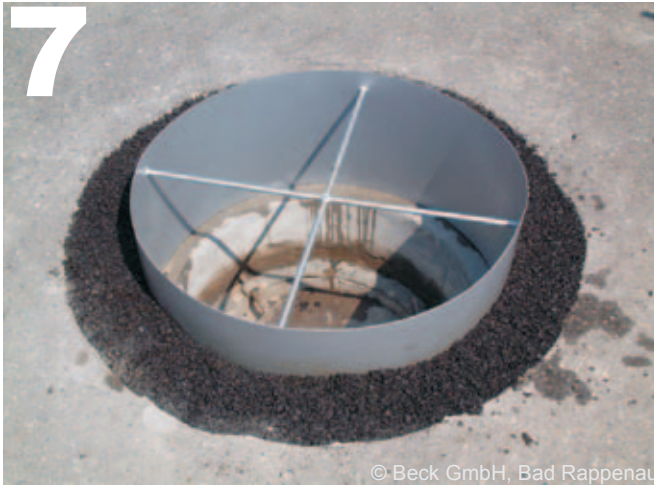
Arbeitsraum mit Asphalt auffüllen
