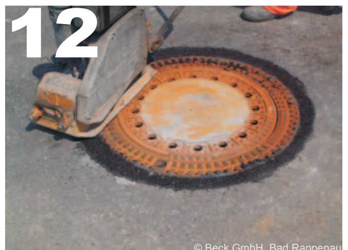
Schachtabdeckung Bituplan® auf Fahrbahnniveau einrütteln
