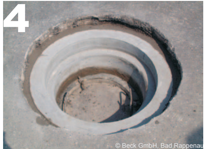
Betonringe vollflächig vergossen
