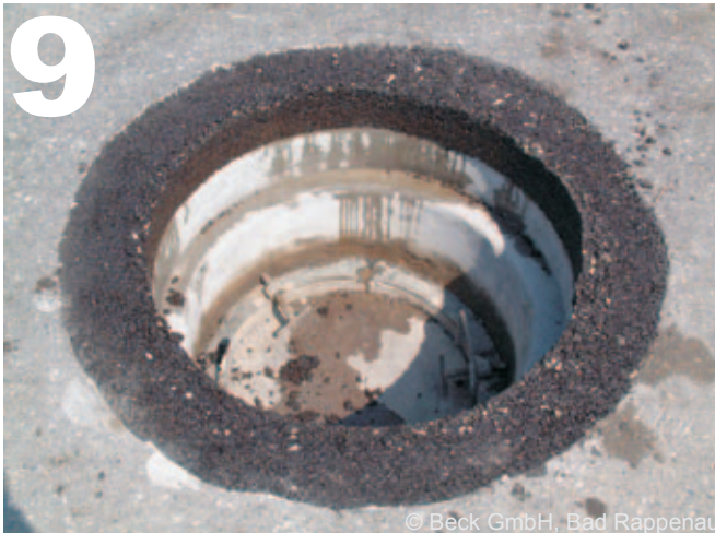
Einbauschalung entfernen
