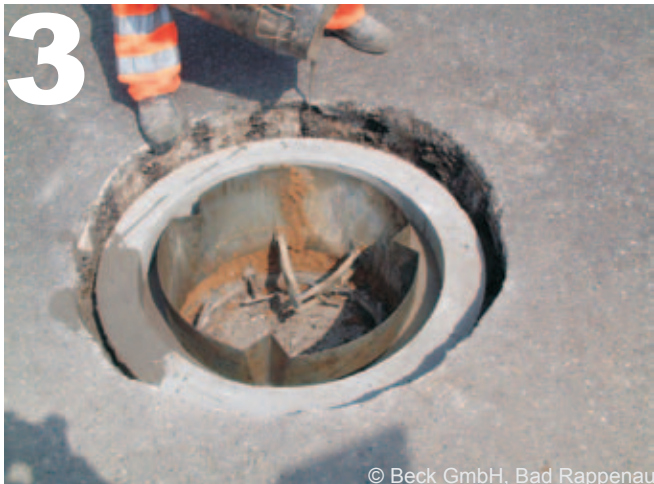
Schalung einsetzen und Betonringe vollflächig mit EBRALIT®-Schachtvergußmörtel vergießen
