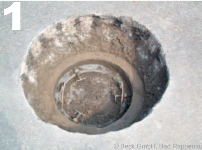
Defekte Abdeckung ausbauen und Konus freilegen
