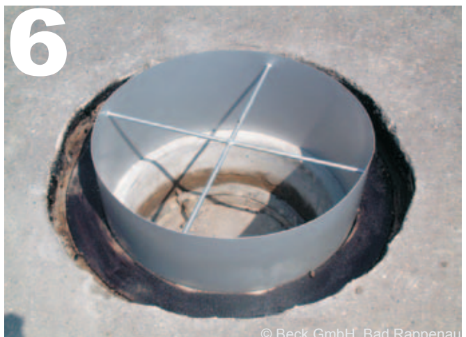
Einbauschalung einsetzen
