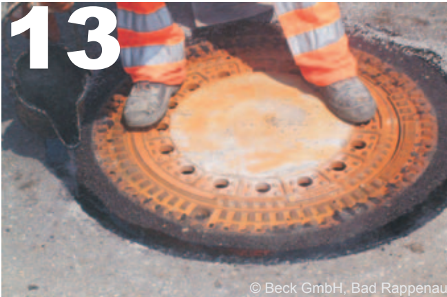
Nahtverguß mit Heißbitumen
