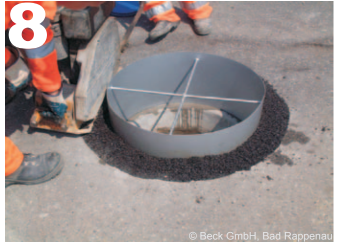
Asphalt vorverdichten
