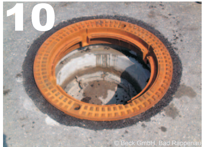
Rahmen der Bituplan® einsetzen
