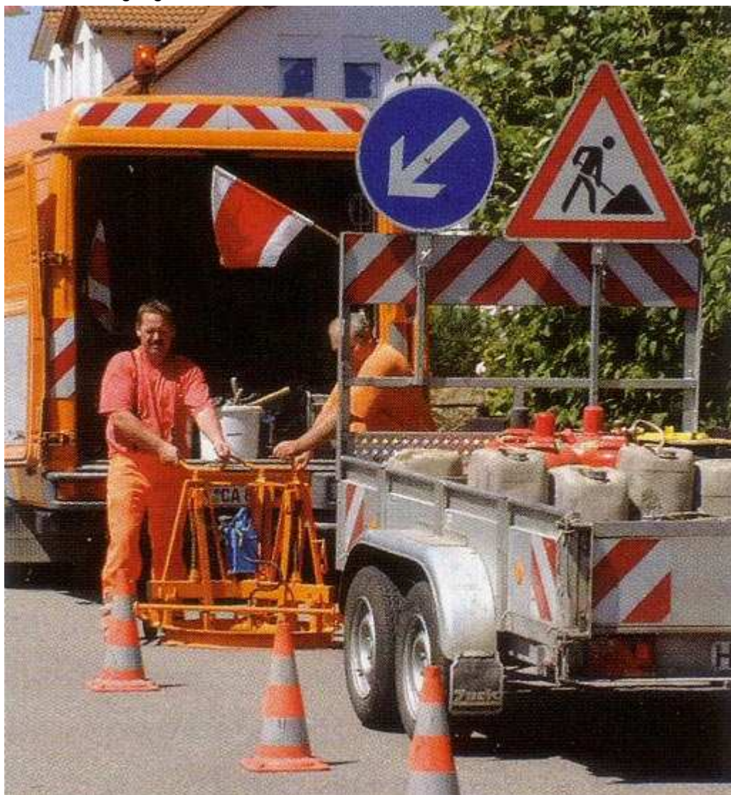
Baustelle: Perfekt eingepasste Schachtdeckel sind das Aushängeschild eines Kanalsystems.
