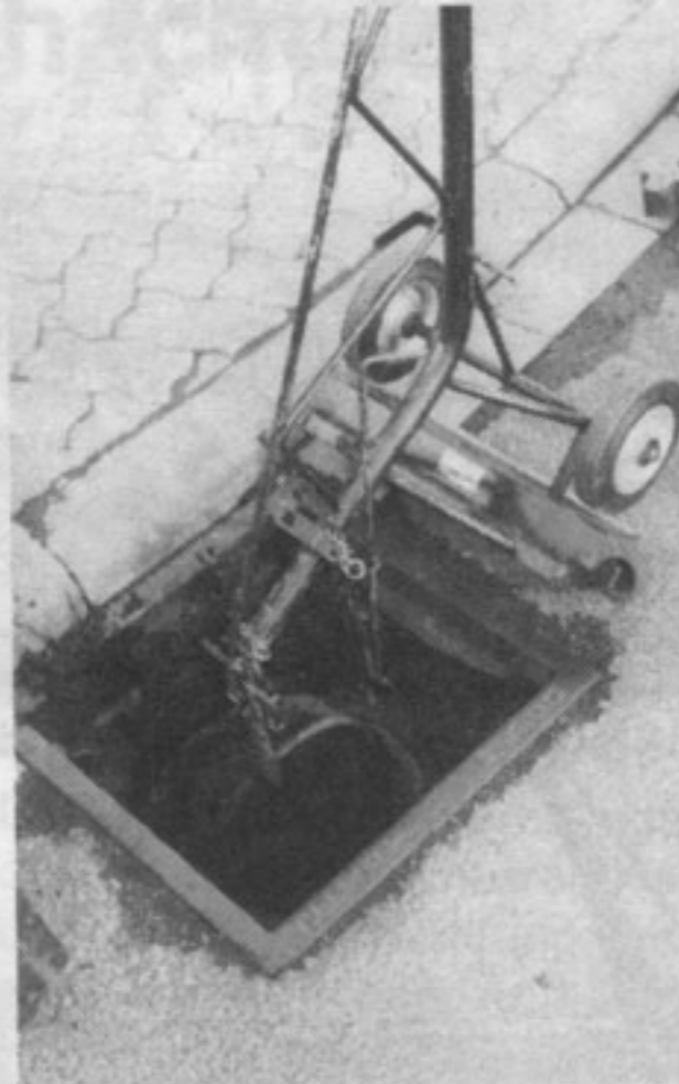
Abb. 9: Schmutzeimer im vorderen Haken eingehängt...
