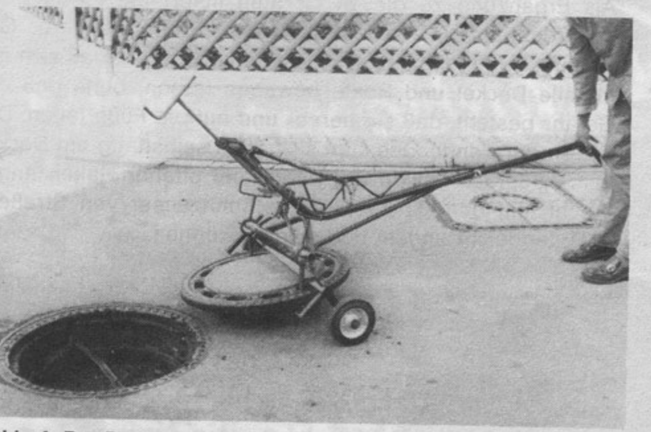
Abb. 4: Der Deckel wurde gelöst und wird abtransportiert.
