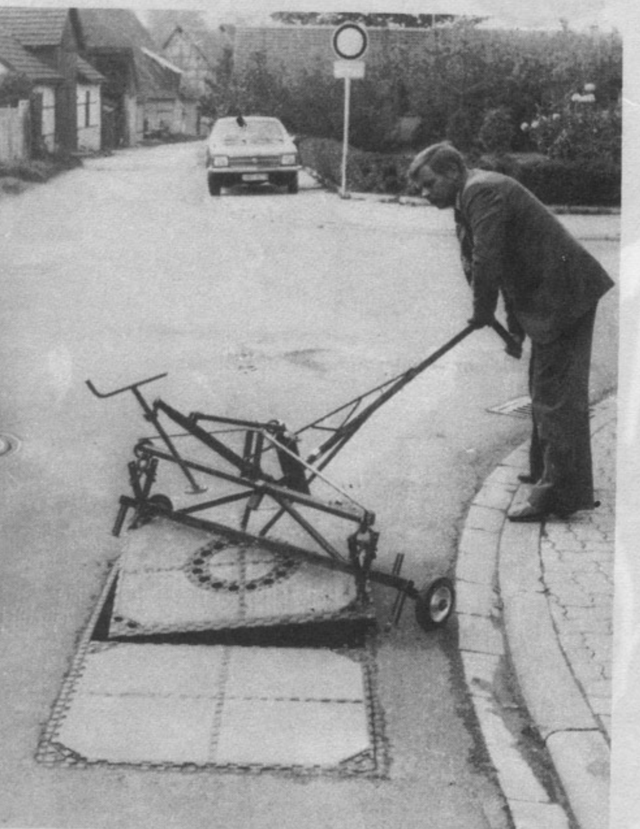
Abb. 6: Wie vor — der Deckel hat sich bereits unter dem Gerät festgeklemmt.
