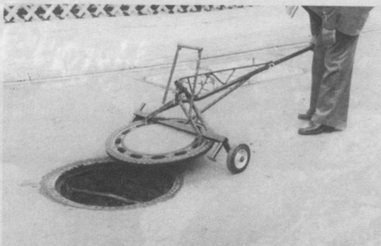
Abb. 2: Der Schachtdeckel wurde aufgehoben und wird beiseitegefahren.
