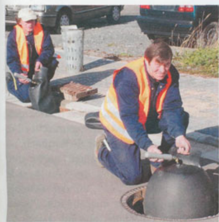
Schachtabdichtblasen im Notfall-Einsatz
