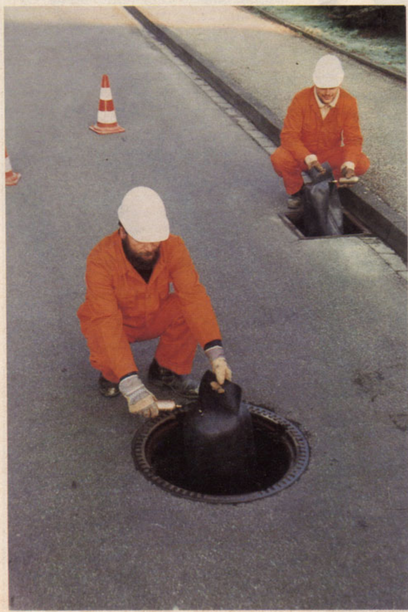
Oben: Bild 1, die Blase hat in einem kleinen Kasten Platz; unten: Bild 2 und 3, Einsatz an Regeneinlauf und Kanalschacht
