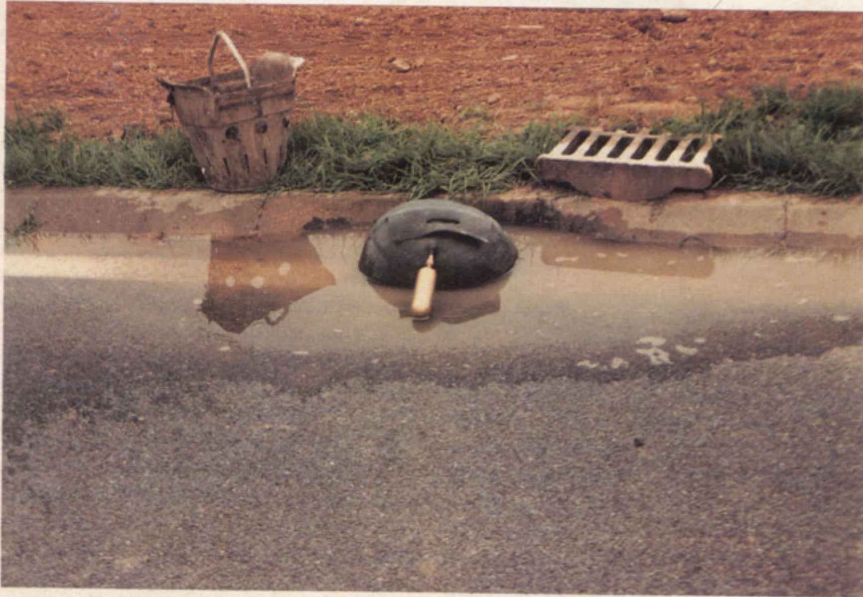
Oben: Bild 4, der Schacht ist dicht; unten: Bild 5, deutlich wird sichtbar, wie widerstandsfähig die Blase ist
