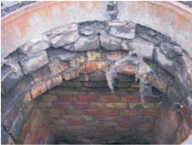
defekter Schachtunterbau ...
