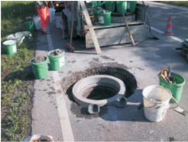
Adapterring ausrichten und vollflächig in EBRALIT ® eingießen
