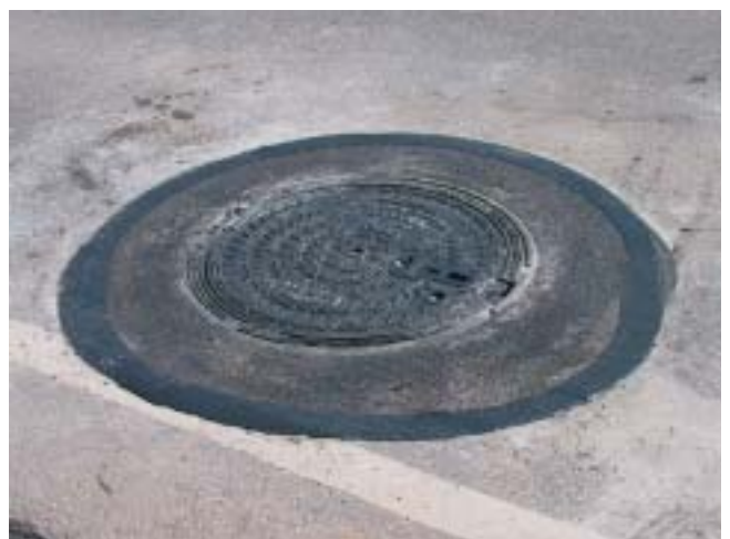
fertiger Einbau nach ca. 45 Minuten später
