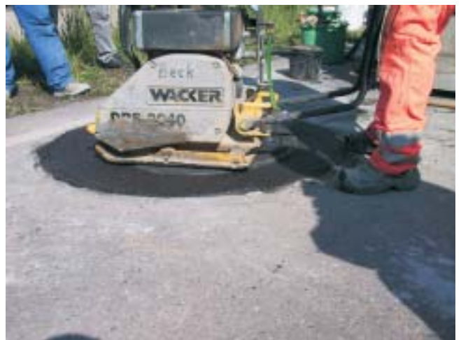
Abdeckung einrütteln EBRALIT ® ist bereits voll belastbar
