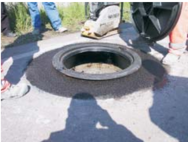
Rahmen der Abdeckung einsetzen
