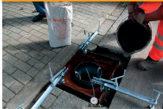
6. Mit Voranstrich vorbereiten, reaktiven BECK-Asphalt einbauen und vorverdichten
