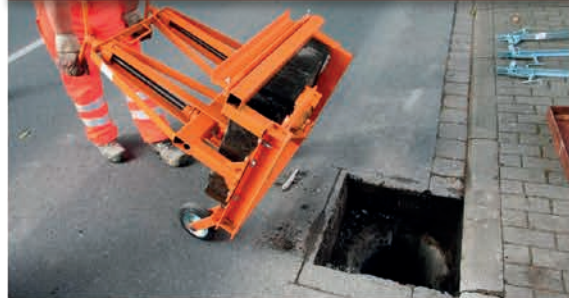
4. Einsatz von Luftmantelschalung, vergießen mit EBRALIT-Schachtvergussmörtel
