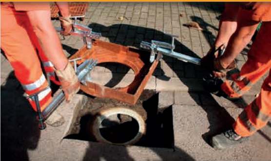
5. Unterbau erstellt mit EBRALIT - ca. 5 min
