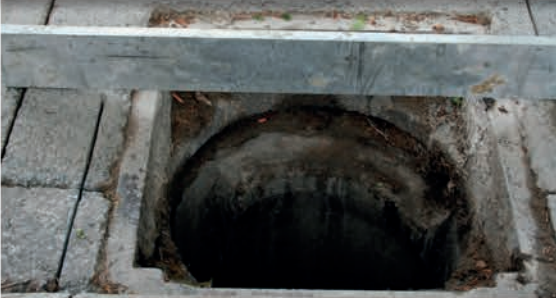
3. Justieren des neuen Aufsatzes mit Schachtrahmeneinbaugerät
