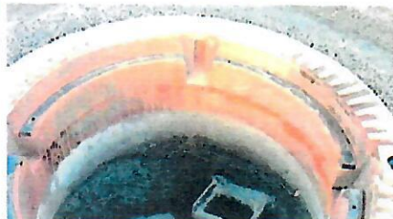
Bei diesem Blick in den geöffneten, fertigen Schachtestieg sieht man den hellen gegossenen Schaft, auf dem der Außenring des Deckels aufsteht.
