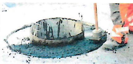
Der Asphalt wird mit Spezialwerkzeugen fest verpresst.
