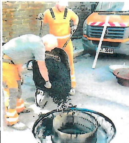
David Janeczek und Jörg Mickan (links) von der Firma Beck füllen den heißen Asphalt auf den frisch vergossenen Kanalschaft. FOTOS: CP-CARSTEN WAGNER
