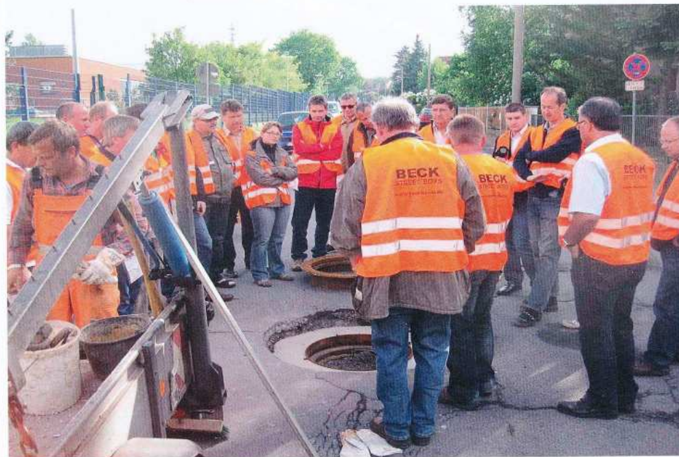
Abbildung 4: Kursteilnehmer in Dresden verfolgen interessiert den Einbau einer einwalzbaren Schachtabdeckung
